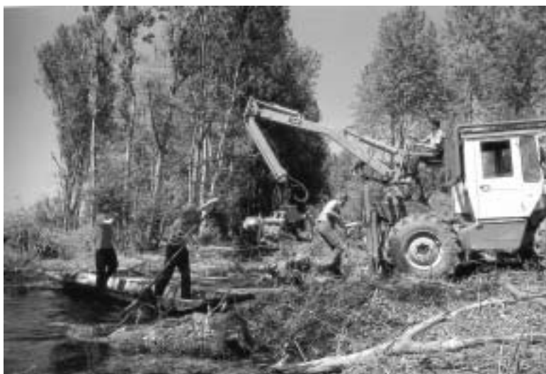
Chantier SAVA en cours © Gérard LACOUMETTE
