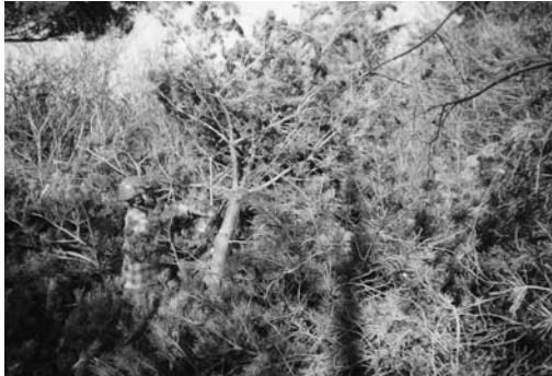
Zone de chantier avant et après travaux
