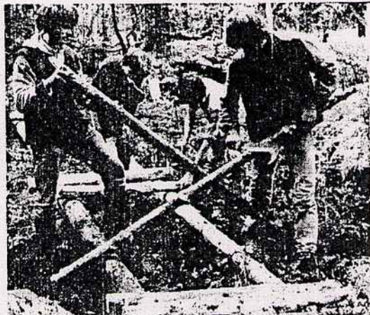
Le chantier des Hautes Vosges: des pontons sur les sentiers, pour stopper l'érosion des sols humides.
