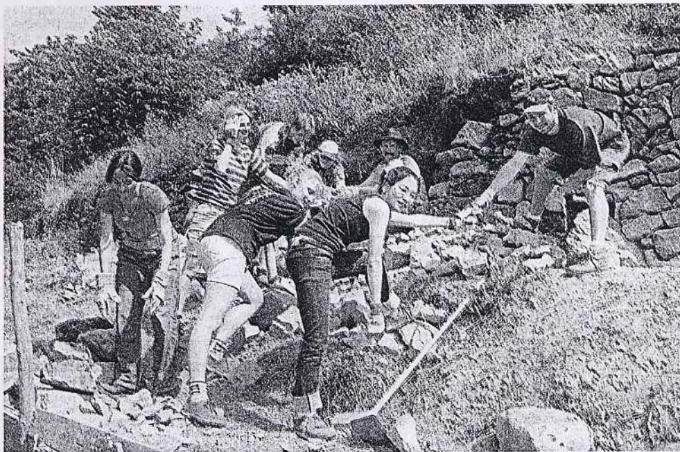
Trois semaines de chantier en pleine nature, ça crée des liens.
